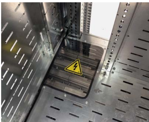
Montage du kit de raccordement réf. 4 046 93. Couples de serrage : 50 N · m
