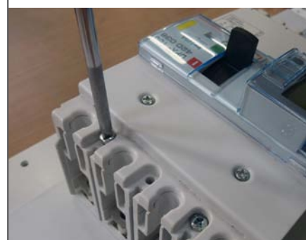
Fixer le DPX 3 grâce aux vis fournies avec le disjoncteur (couple de serrage 1 N·m).
