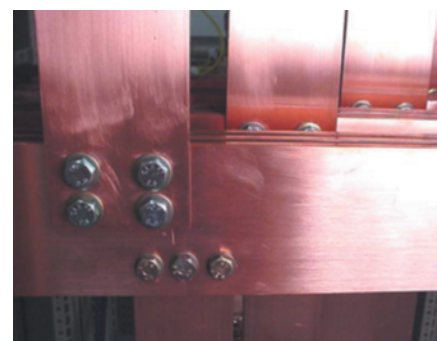
Raccordement double : barres 100 x 10 (3200 A) et barres 80 x 10 (2500 A) sur barres communes 120 x 10
