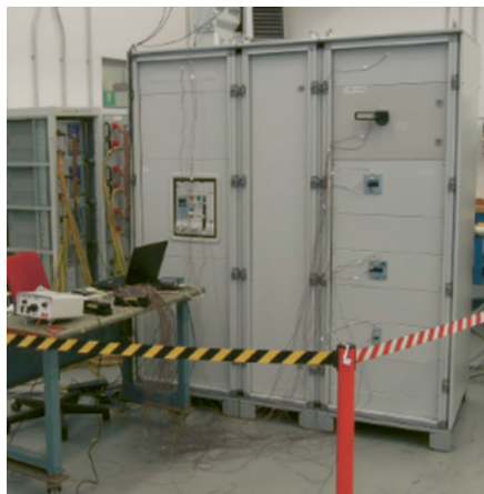
Mesures des limites d'échauffement dans une enveloppe XL 3
