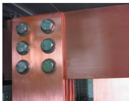
Raccordement sur barres 120 x 10 (4000 A)
