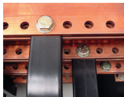
Serrage direct de barres souples de 5 mm d'épaisseur entre deux barres rigides à même espacement
