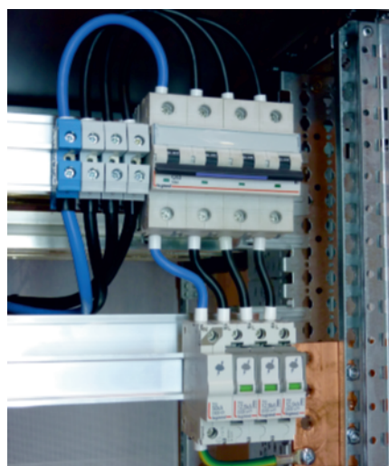
Autre exemple de réalisation des liaisons L1, L2 et L3.
