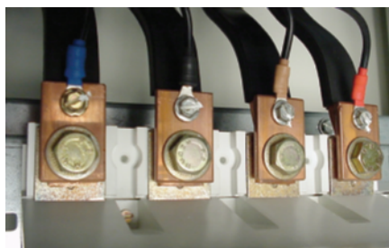
Exemple de raccordement sur plaque cuivre rapportée sur la connexion. Les vis sont équipées de rondelles contre le desserrage
