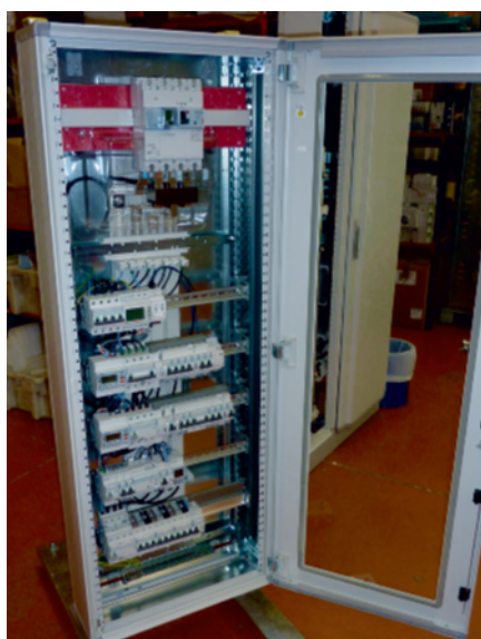
Exemple : test de fonctionnement sur portes, plastrons, verrouillages, etc.
