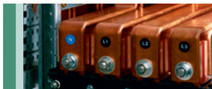
Exemple : les phases doivent, au minimum, être repérées N, L1, L2, L3, aux extrémités et aux points de raccordement.
