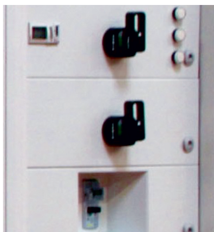
Le respect des règles de montage garantit l'IP annoncé des enveloppes XL 3
