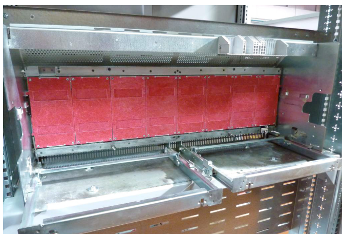
Base vide pour DMX 3 - taille 3 - 4 pôles - réf. 0 289 14 et le bornier réf. 0 290 12
