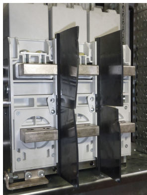
Cloisons de séparation montées sur DMX 3 3P fixe
