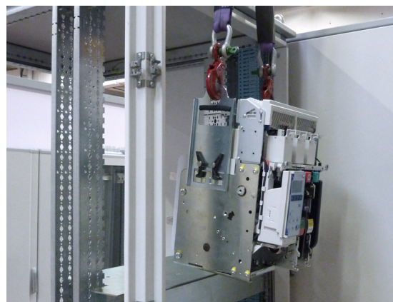
Mise en place d'un DMX 3 fixe
