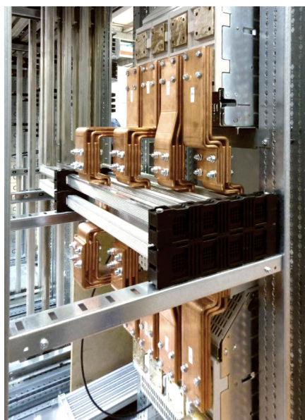
Kit de liaison entre inverseur DMX 3 taille 1 débrochable et un jeu de barre de transfert en aluminium
