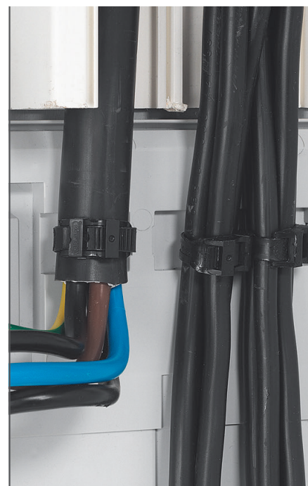
Arrimage des câbles
