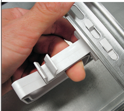
Mise en place d'un bracelet de guidage pour la circulation horizontale
