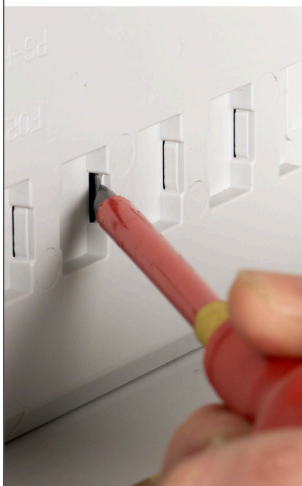
Défonce des passages
