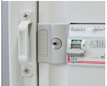
La gâche se fixe du côté opposé aux charnières par 2 vis
