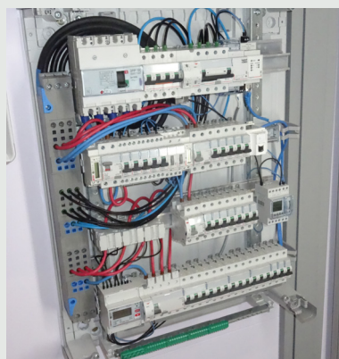
Alimentation d'une rangée en triphasé avec le peigne à tête trident
