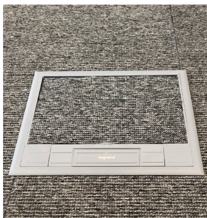
Corte do revestimento em esquadria
