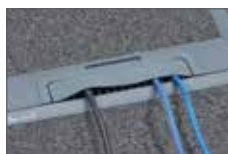
Saída de cabos flexível
