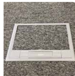
Corte do revestimento em esquadria
